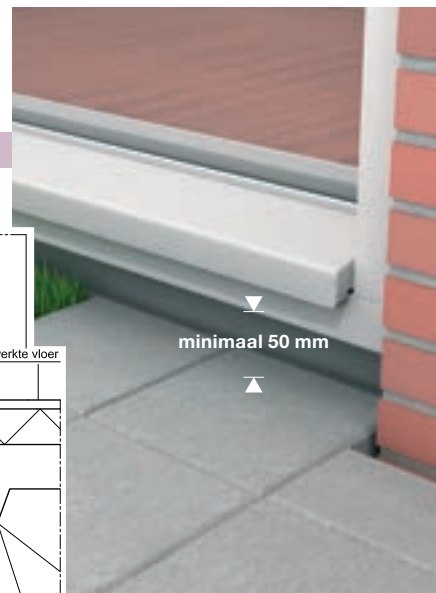
Afstand onderkant kozijn - bestrating
